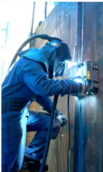
Saldatura di testa verticale ascendente con rotaia di guida
