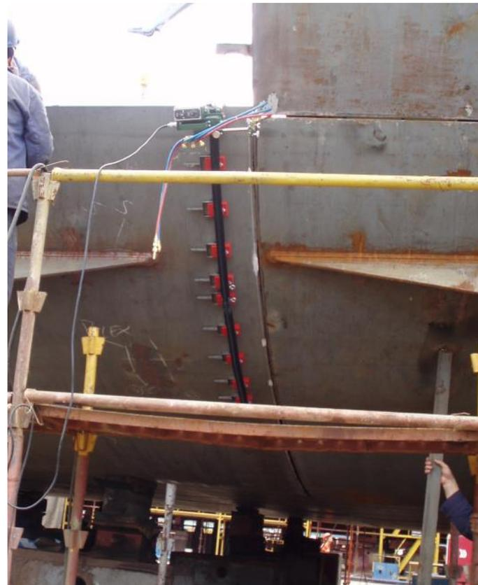
*Preparación soldadura realizada con 2D rail*
